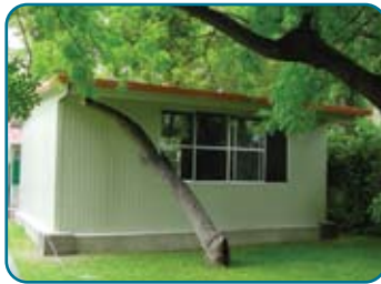
Aplicación de Multytecho
